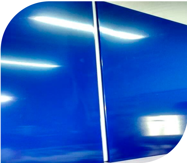
Junta sem selante (com ACM aplicado na junta)
